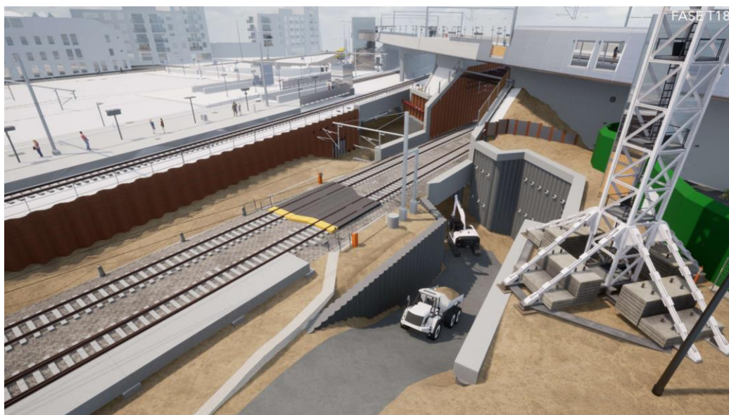
Figur 3-5 3D-model. Arbejdsproces med udgravning til gangtunnel. Bemærk, at sporforbindelsen for Øresundsbanen er retableret.
