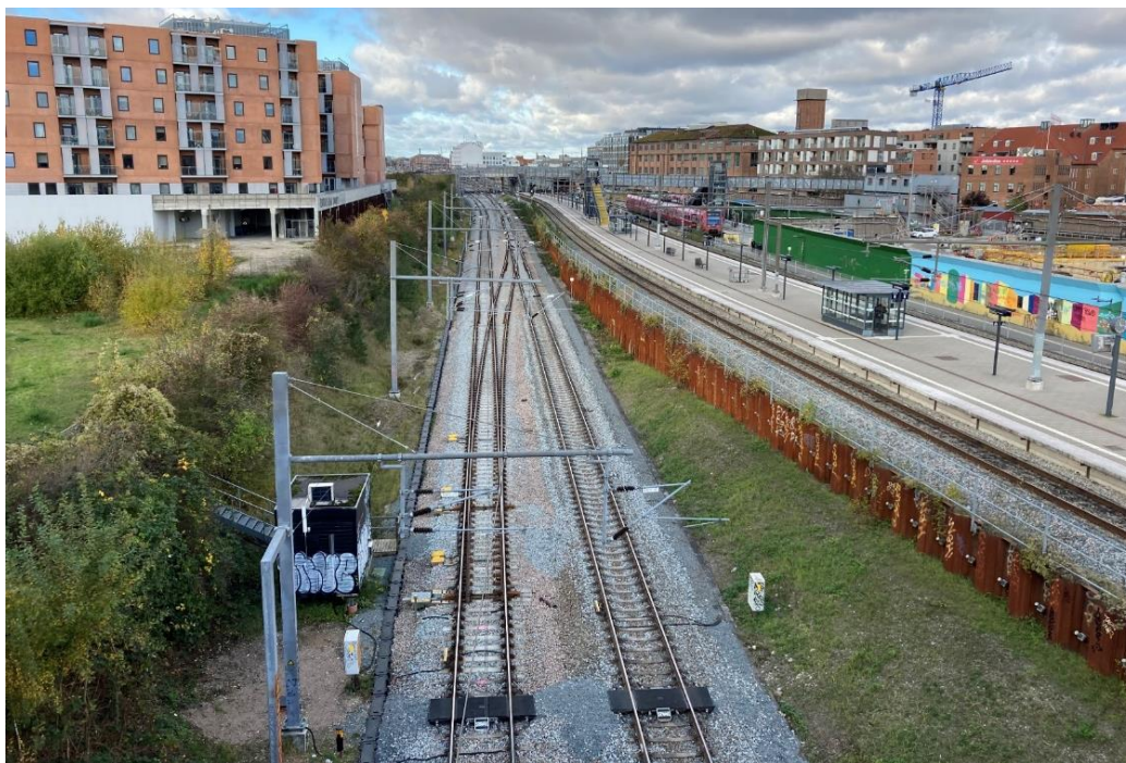
Foto 1-1 Foto af Øresundsbanen set fra Køge Bugt-banen mod Gammel Køge Landevej. Til højre ses København-Ringsted-banen og Metroselskabets byggeplads.
