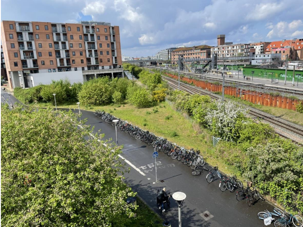
Foto 13-1 Foto af areal, hvor der etableres byggeplads, set fra Køge Bugt-banen. De mindre affaldsbunker er skjult af beplantning.
