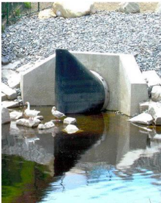
Figur 3: Principmodel for udløbsbygværk
