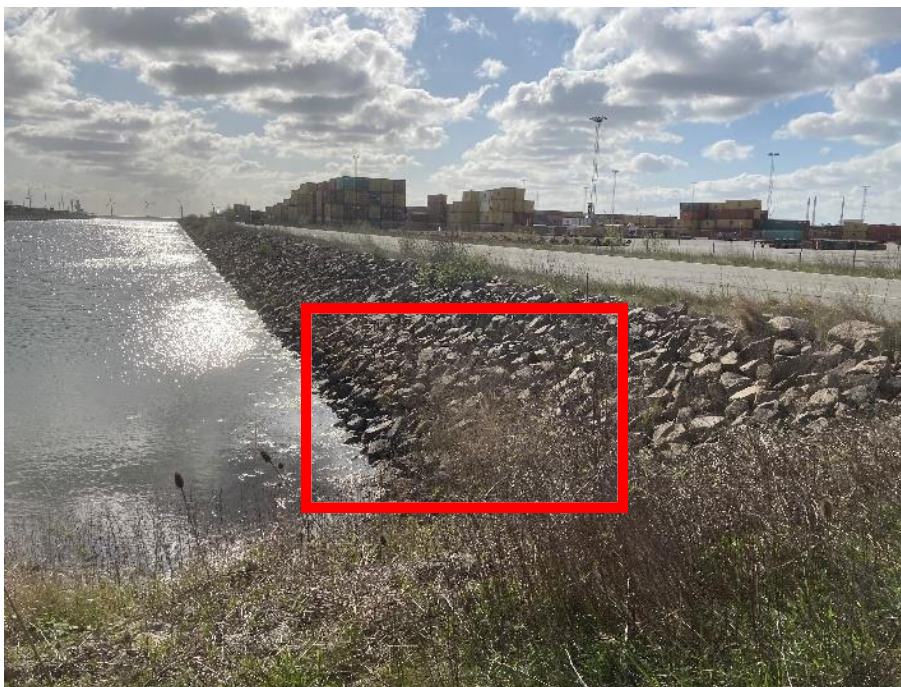
Figur 2: Område for planlagt placering af udløbsbygværk ved Skudeløbet set fra krydsningen af Skudløbet i sydøst retning.
