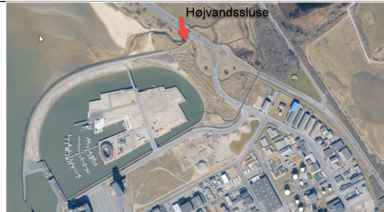
Figur 8. Højvandssluse ved Sædding Strandvej/Hjertingvej
