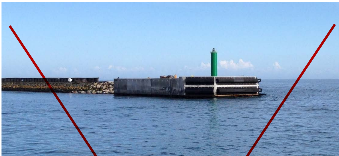
Figur 5-6 Eksempel på vertikalt molehoved med betonhammer og påmonterede gummifendere til absorbering af energien i tilfælde af skibsstød. Fenderne ses som de sorte elementer på højre del af molehovedet. Bemærk endvidere det grønne fyr.
