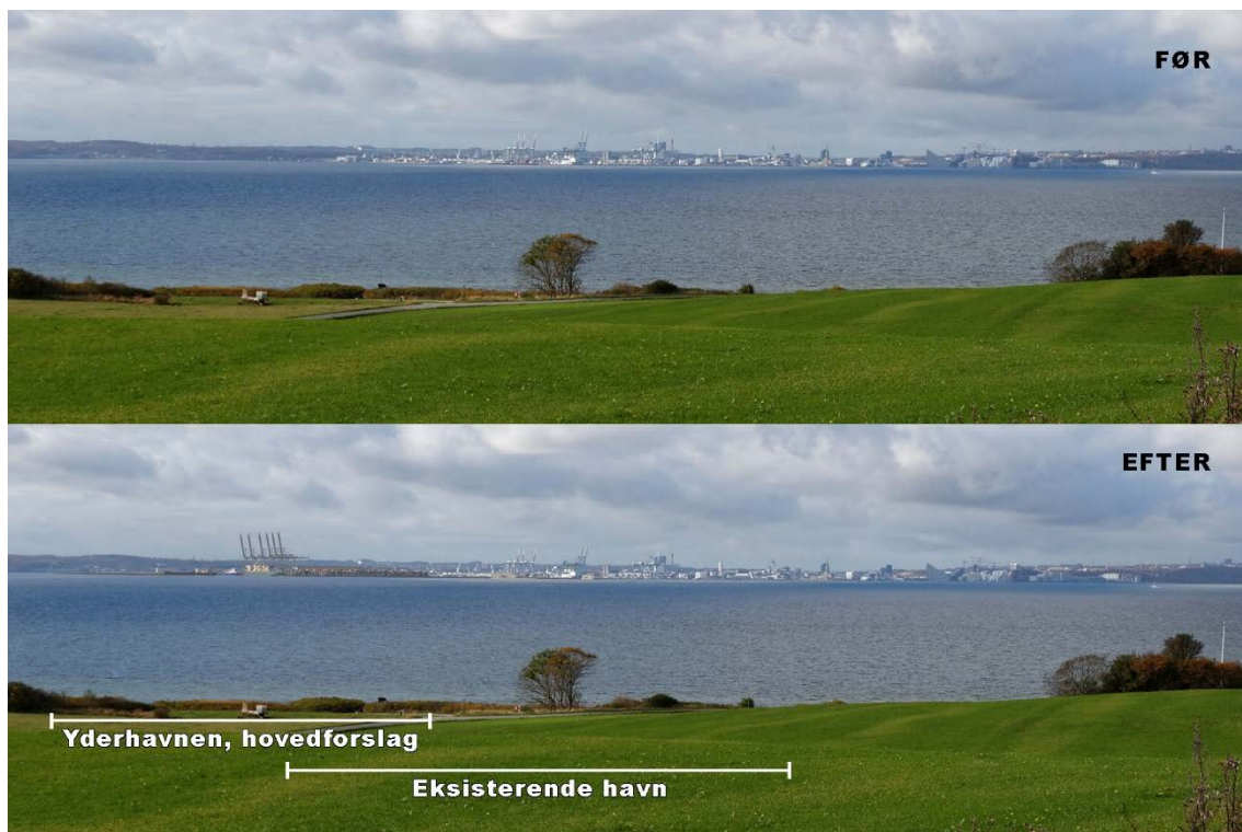
Figur 7-25 Eksisterende og fremtidige forhold set fra visualiseringspunkt 12) Skødshoved, øst for projektområdet. Der henvises til Bilag 1 for større version af billederne.
