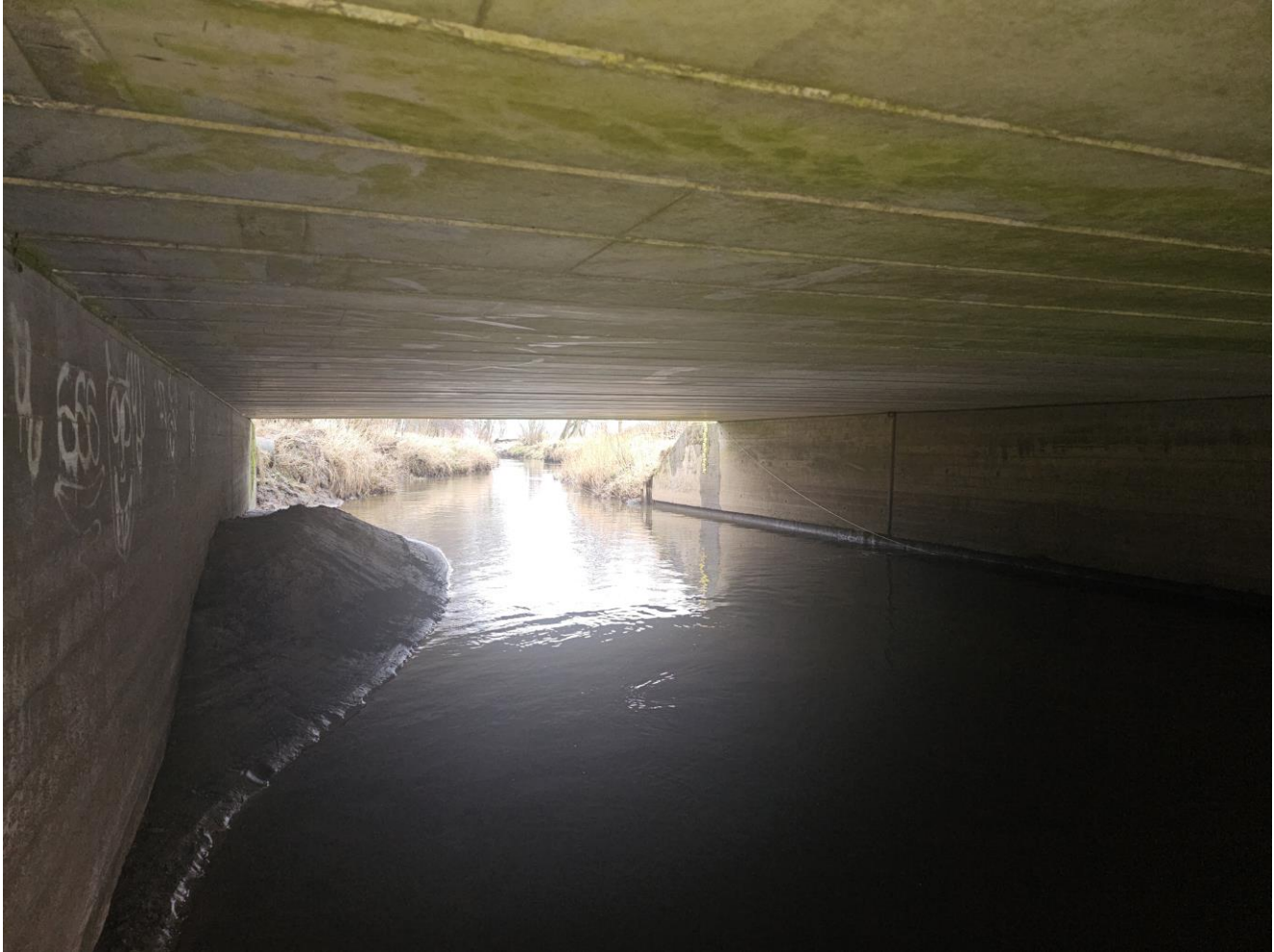
Figur 2.4 Bygværket består af betonelementer på undersiden. Der blev ikke observeret nogen hulheder eller sprækker, der kan benyttes som længerevarende raste- eller ynglested for flagermus.
