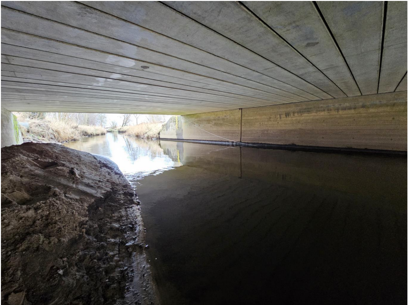
Figur 3.1 Banket på nordlige side af vandløbet.
