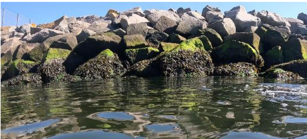
Figur 11: Substrattype 4 – sten. Stenkastning som danner rev og giver mulighed for tilhæftning af makroalger.
