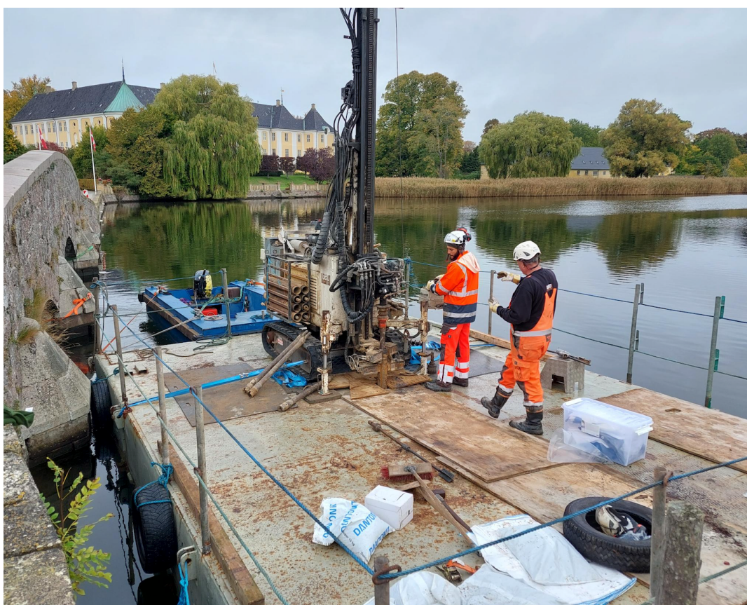
Figur 2: Eksempel på komplet bore-setup.
