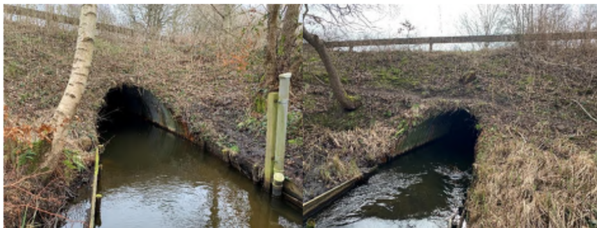
Figur 12: Skråninger omkring bygværket, venstre: Sydlig skråning, Højre: Nordlig skråning.
