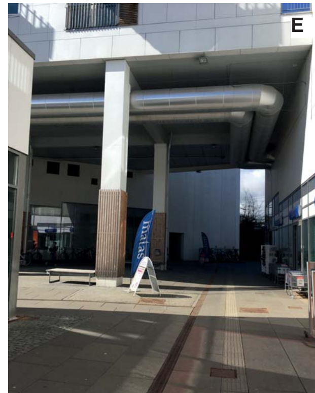
Hjørne ved indgang til tunnel.
