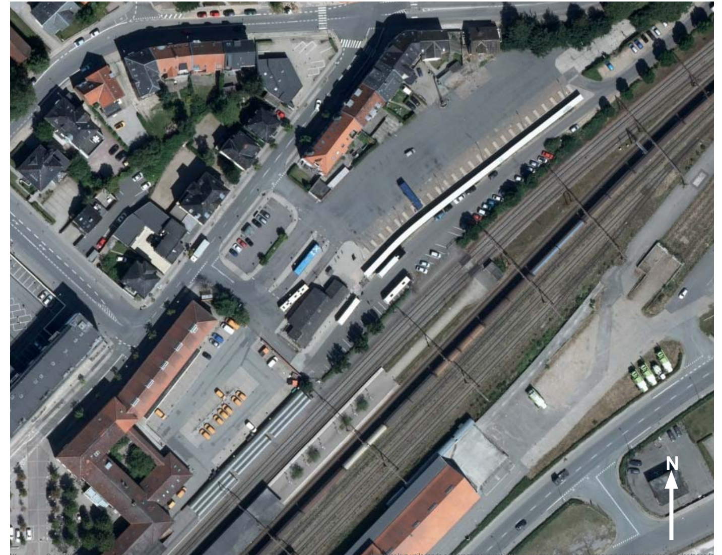
Kolding station før
