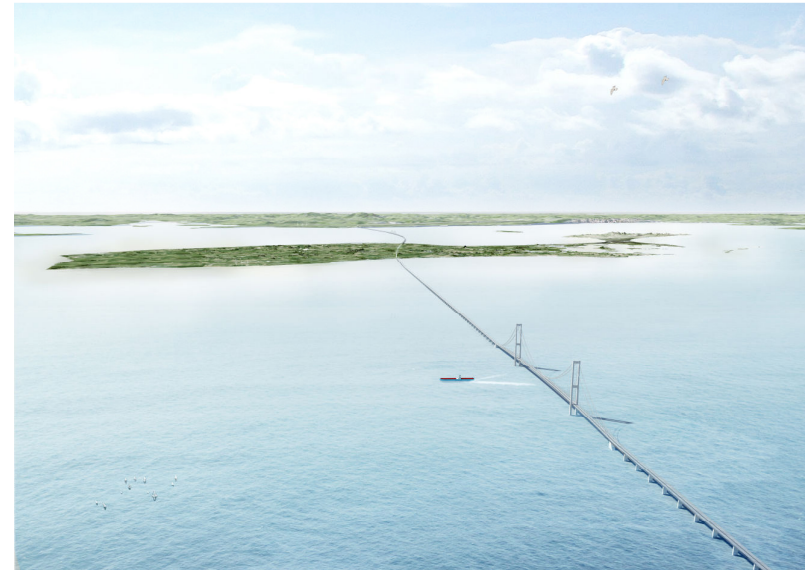
Figur 12. Set fra Sjælland. Banen krydser Kattegat mellem Røsnæs og Samsø på en ca. 19 km lang bro. Fra Samsø til Jylland fortsætter banen på en ca. 20 km lang bro.
