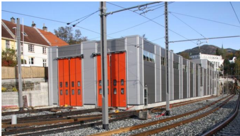
Figur 19. Eksempel på servicehal (Bybanen i Bergen)
