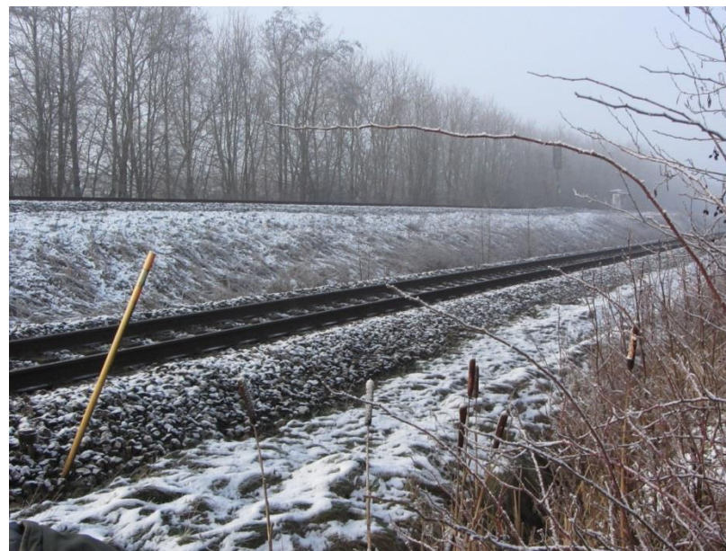
Figur 20. Hovedbanens spor ved Årslev. Det nordgående hovedbanespor ligger 2-3 m lavere end det sydgående hovedbanespor.
