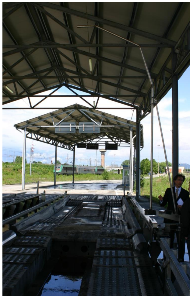
Profilmåling ved gaten til Modalohr-terminalen i Orbassano.
