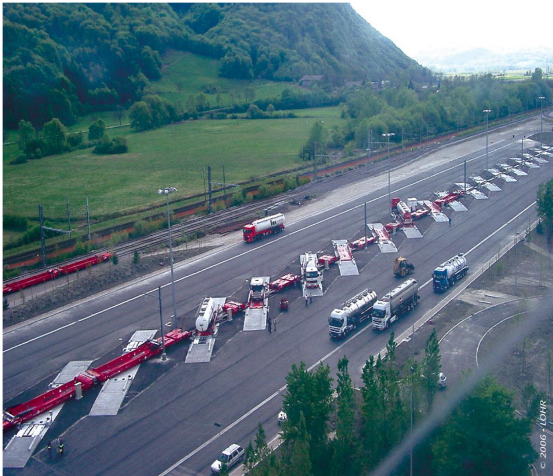
Modalohr-terminalen i Aiton i Frankrig (Kilde:Modalohr).
