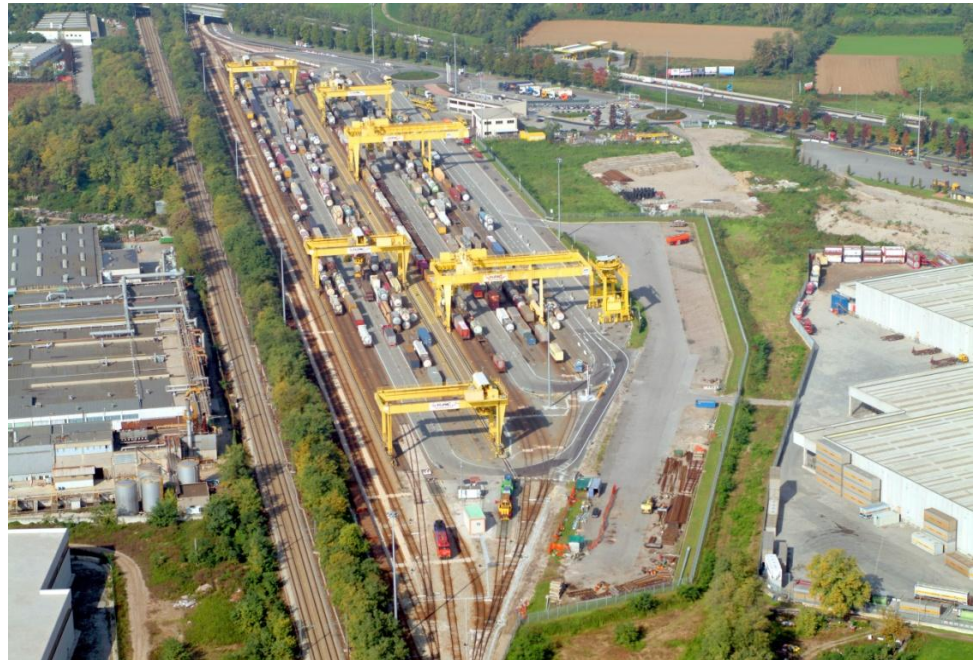
Oversigtsbillede af Busto-terminalen. Gaten til begge terminaler ses øverst midt i billedet. Til højre skimtes nogle af de lagerbygninger, der er beliggende i umiddelbar nærhed af kombiterminalen. (Foto: Hupac).
