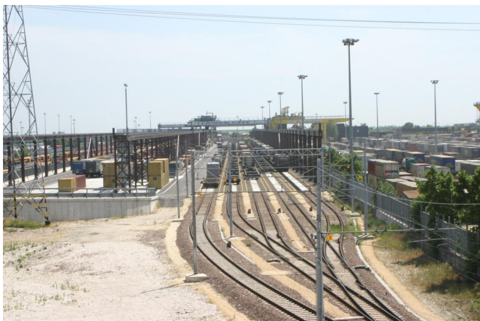
I midten af billedet ses de 5 læssespor i transshipment-modulet. Til venstre ses depot-modulet.
