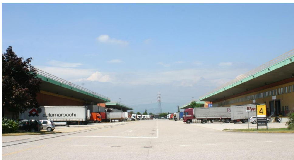
Lagerbygningerne i logistikområdet udlejes til transport- og logistikvirksomheder.
