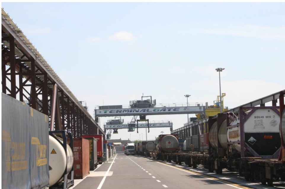
Transshipment-modulet med to portalkraner. Til højre ses læssesporene, i midten de to lastbilbaner, og til venstre en række til midlertidig henstilling af lasteenheder.
