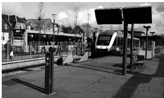
Figur 9. Fra toget kan man let se om bussen er kommet, her Esbjerg Station
