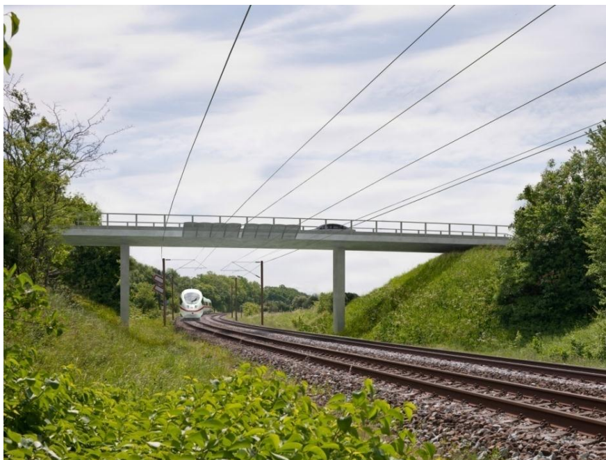
Figur 37. Elektrificering under vejbro
