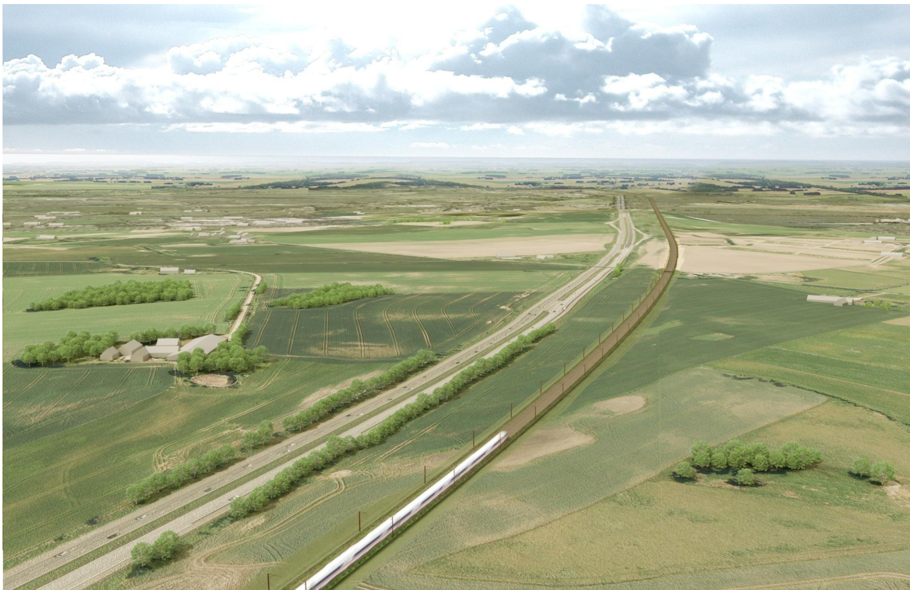
Figur 11. Den nye højhastighedsbane på Vestfyn placeres så tæt som muligt på motorvejen for at begrænse støj, barriereeffekter og landskabspåvirkning mest muligt.
