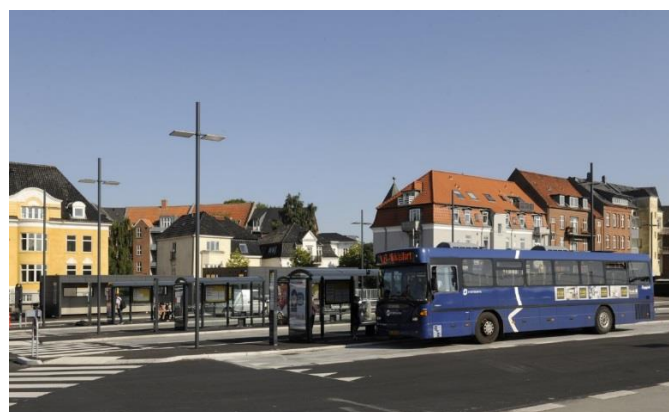
Billede: Ny stationsforplads i Kolding
