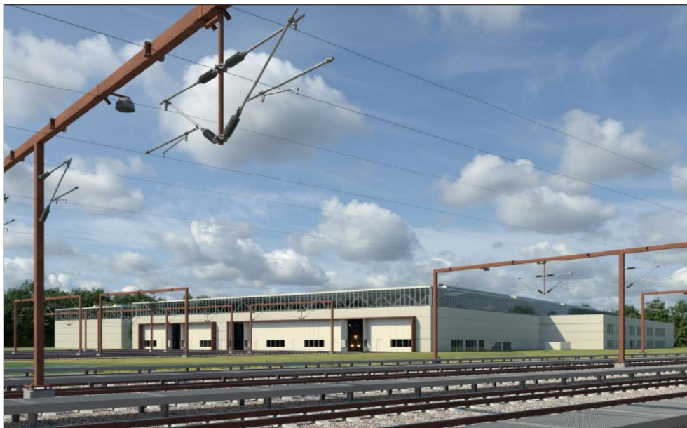
Figur 3-5 Værksted set fra nordøst. Den lave bygning er administrationsbygningen. Længst mod syd ses komponentværkstedetsbygning.
