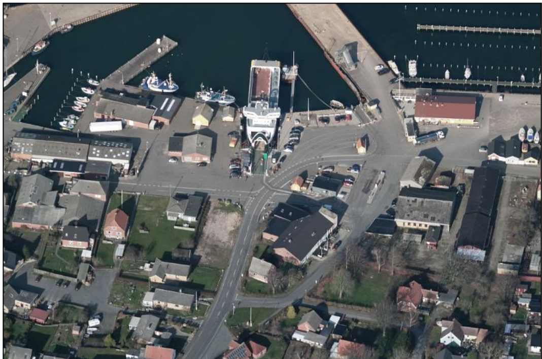
Figur 9-8. Skråfoto over det centrale havneområde i Søby Set mod nord. Det ses at Havnevejen fortsætter ind på Søby Havn. Det ses også at el-færgen Eller er i havn og at der inden havnen, på venstre side af havnevejen, er etableret et opmarchareal for lastbiler (Kortforsyningen, SDFE Skråfoto 26.02.2019).
