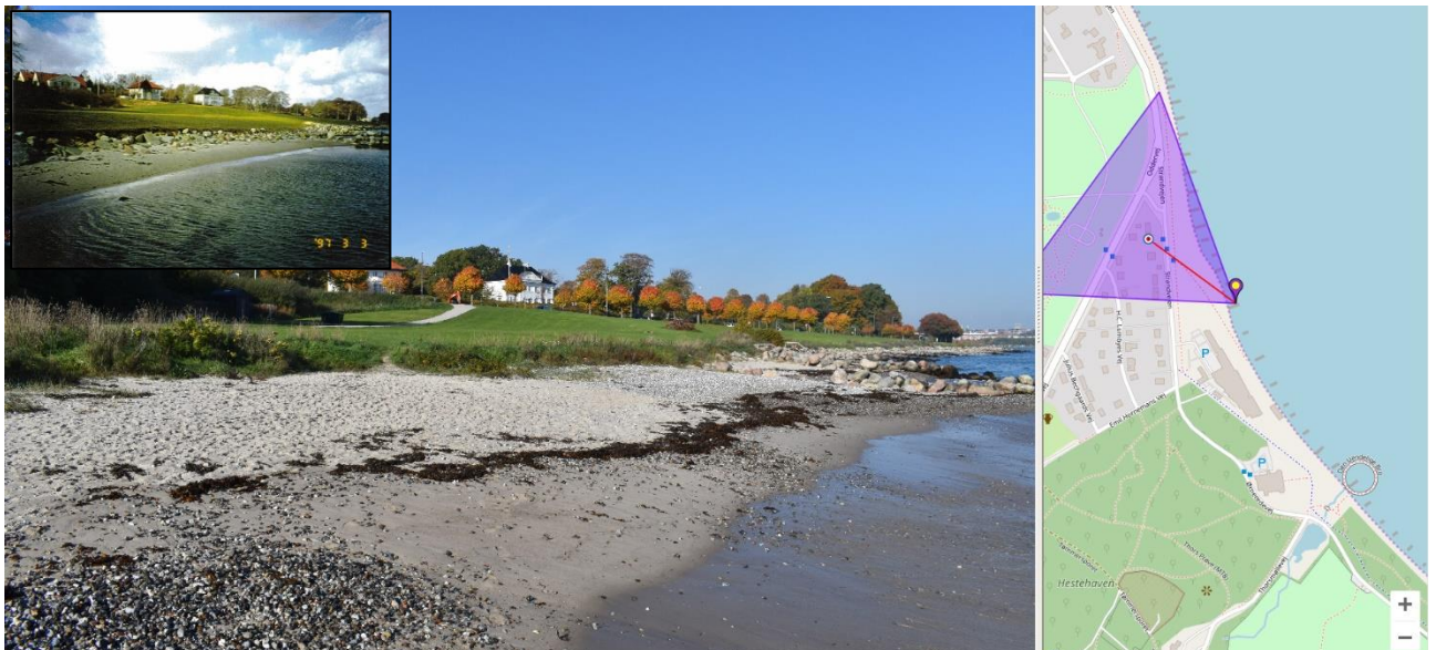
Foto 8 Kysten nord for Hotel Marselis. Et foto fra DHIs kyststudie i 1997 fremgår øverst til venstre. Forstranden er sandet og beskyttet med høfder pr. ca. 30-40 m. Langs bevoksningslinjen starter der ca. her en skræntfodsbeskyttelse, som bliver stadig mere massiv frem mod Tangkrogen.
