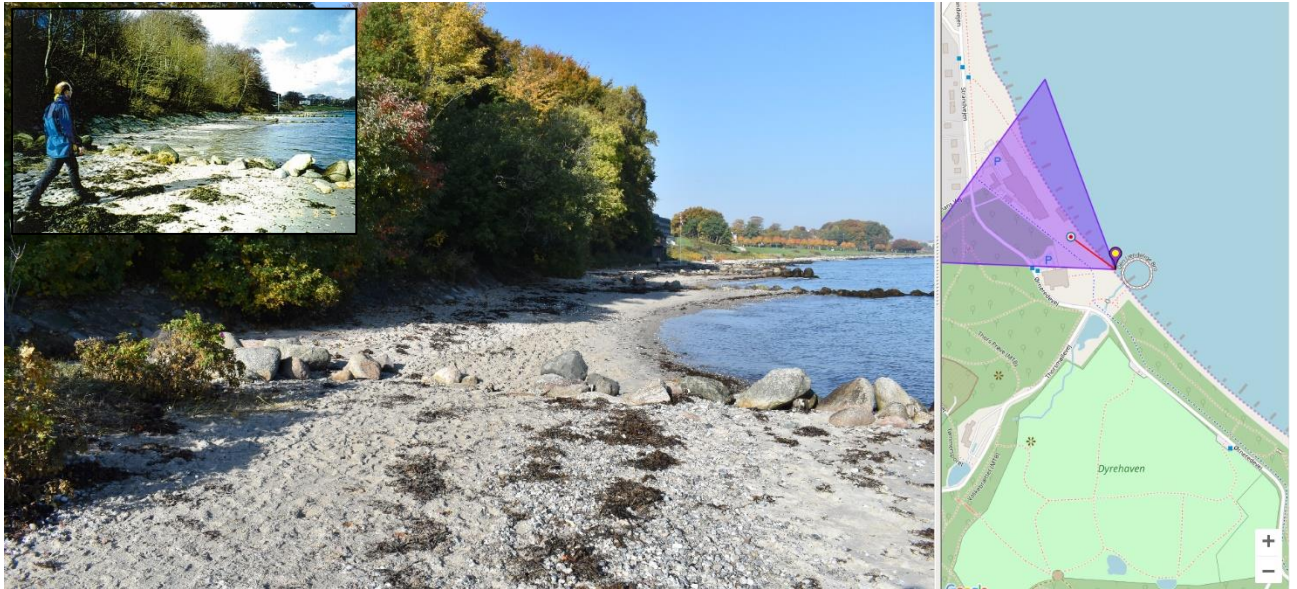
Foto 7 Kysten foran Varna nær 'den uendelige bro'. Et foto fra DHIs kyststudie i 1997 fremgår øverst til venstre. Langs skræntfoden er der over en ca. 200 m strækning etableret et stenglacis ligesom kysten er beskyttet med høfder pr. ca. 40 m. Forstranden forekommer meget smal på denne strækning, men der er ikke tegn på erosion eller underminering af stenglaciset.
