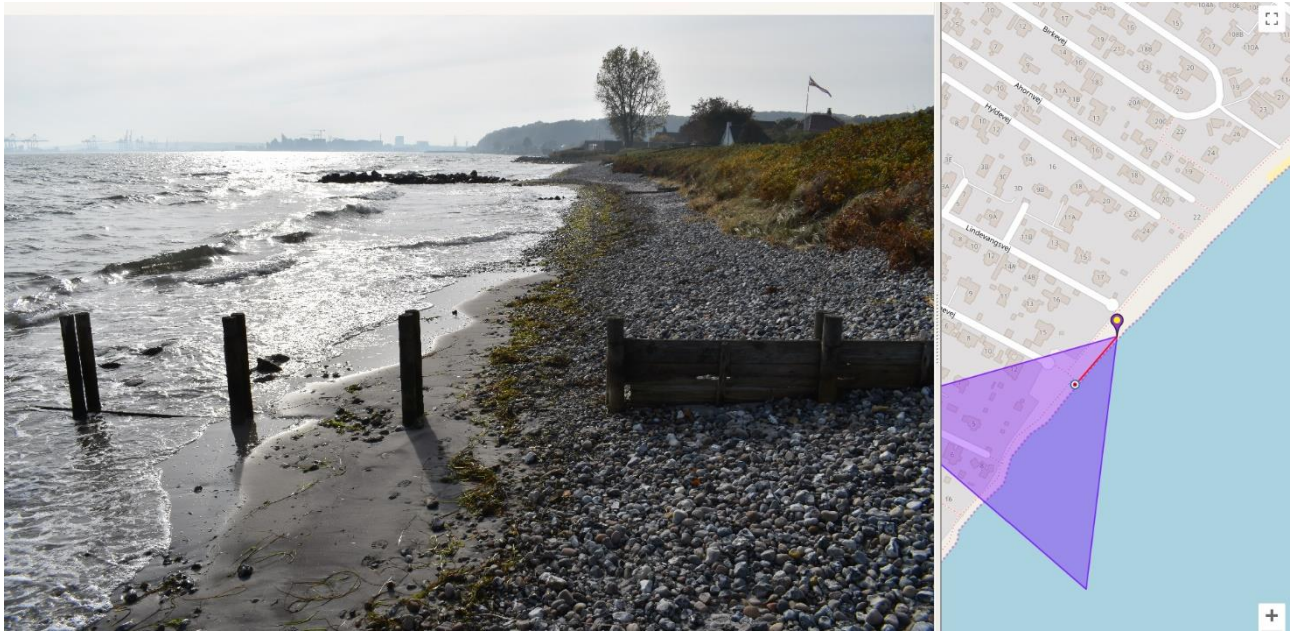
Foto 16 Kysten udfor Lindevangsvej. Stranden er smal og stenet, og beskyttet med uvirksomme træhøfder pr. 30-40 m.
