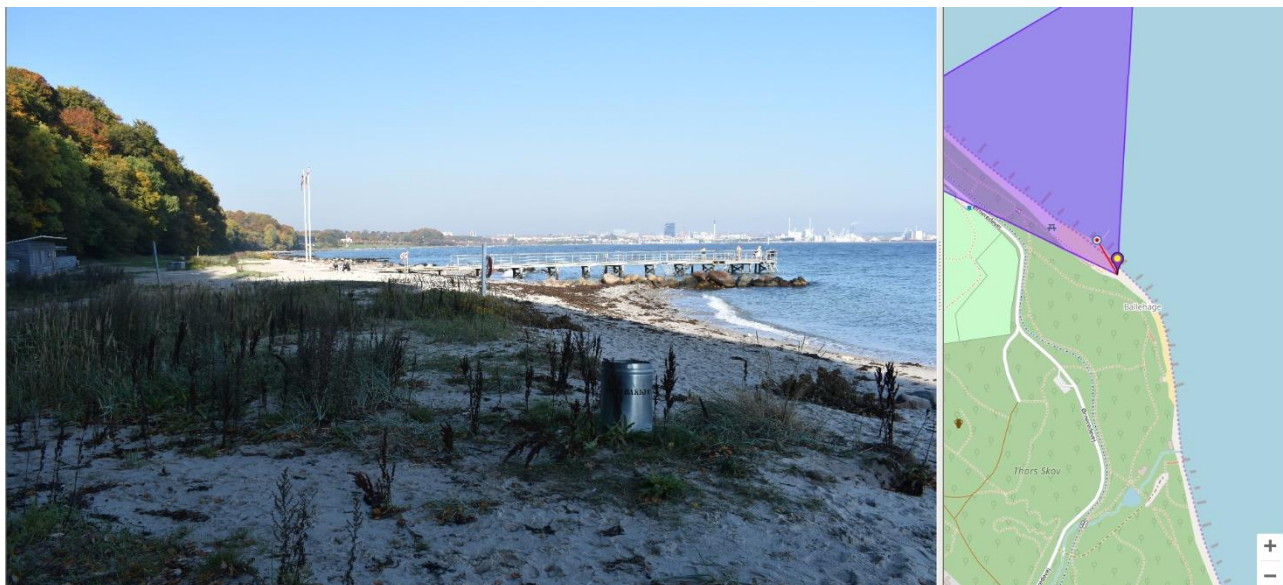
Foto 5 Ballehage strand. Bred sandet forstrand som følge af tilbagetrukket kystkint. Høfder pr. 40m.
