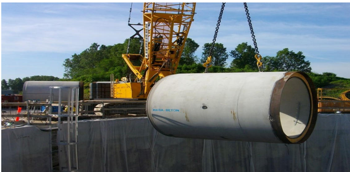
Figur 5.13: Tunnelrør nedsænkes i skakten.
