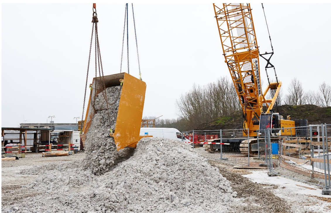
Figur 5.10: Tunnelmuck hejses op fra skakten til bortkørsel.
