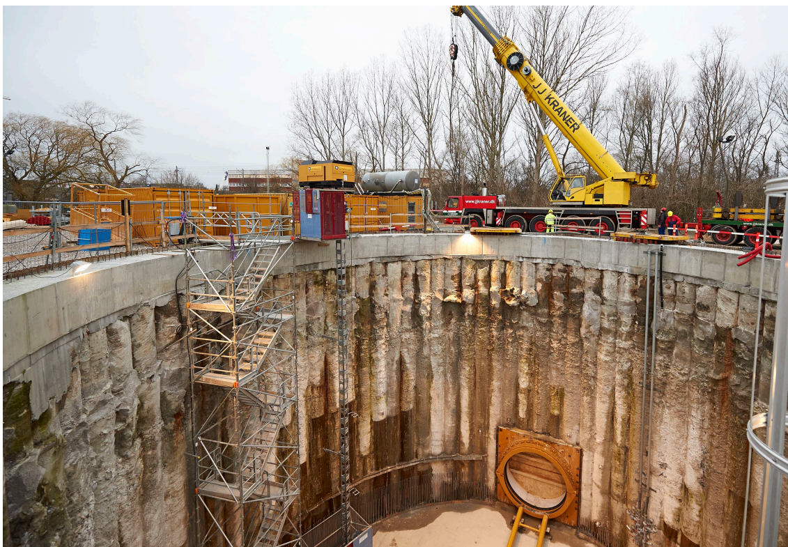
Figur 5.8: Skakt udført med sekantpælevæg
