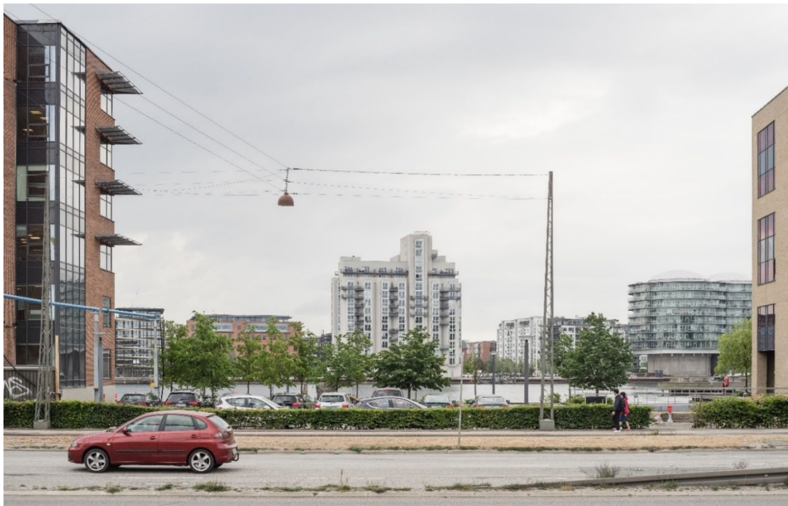
Figur 13.3: Areal, hvor pumpehuset placeres set fra Kalvebod brygge mod sydøst. På billedet ses de eksisterende træer rundt om haveanlæget, der fjernes.
