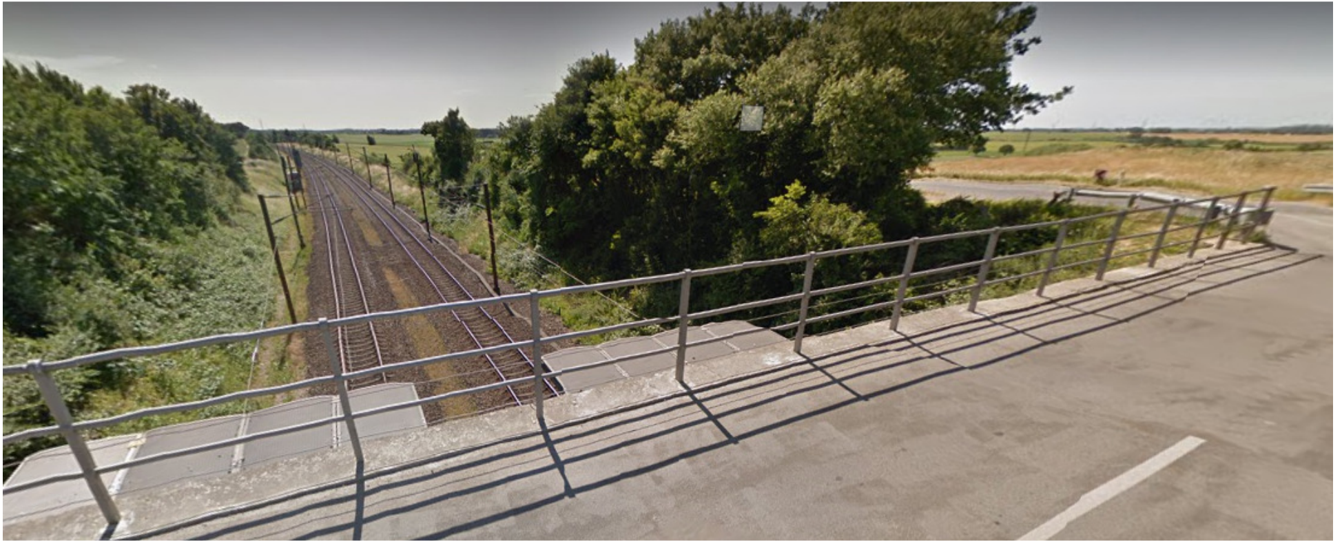
Figur 10: Billede fra google-streetview (billede er fra Strandvejens overføring af banen set mod syd)
