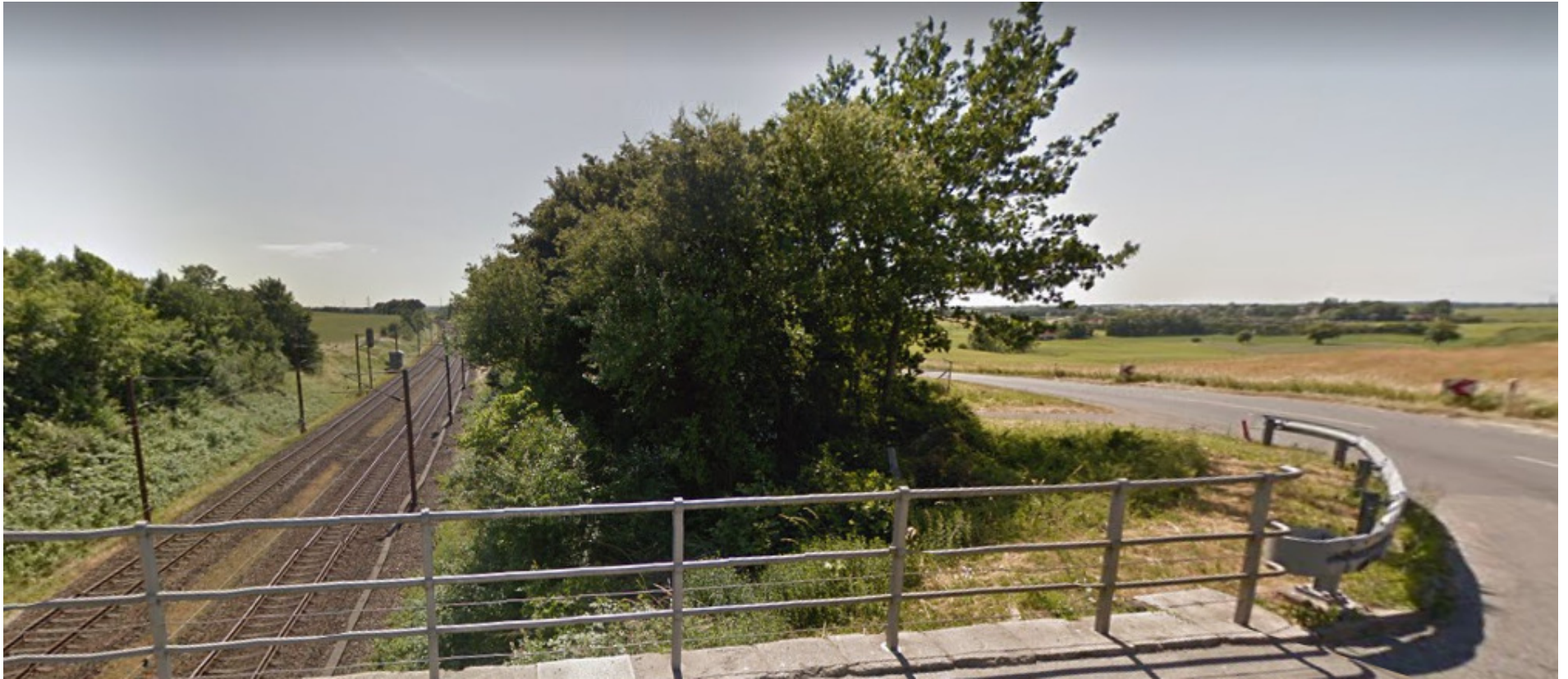
Figur 11: Billede fra google-streetview (billede er fra Strandvejens overføring af banen set mod syd)
