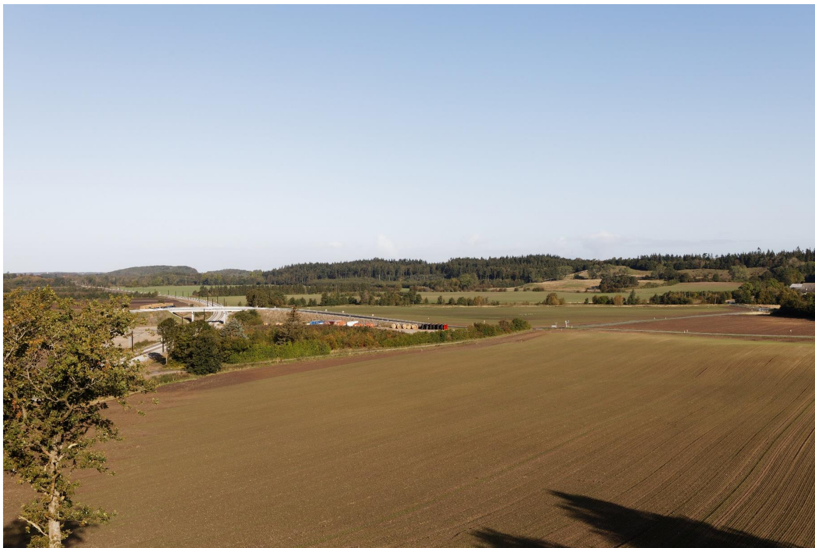
Figur 13 Fotostandpunkt 2, referencescenariet med kørestrømsmaster langs banen set fra toppen af Stejlehøj mod nordvest.
