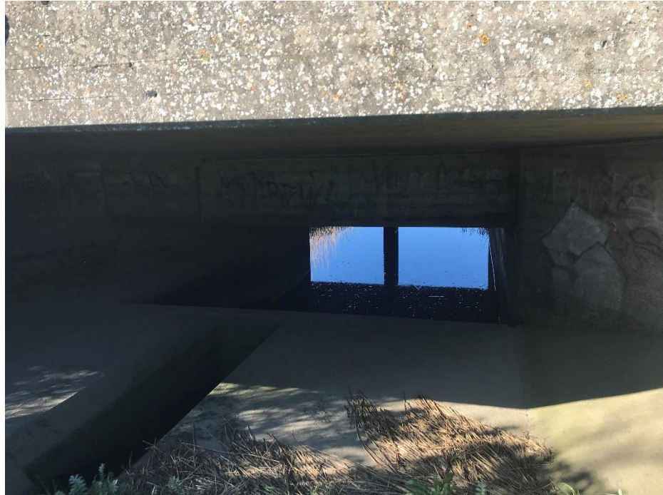
Bygværk på Præstegårdsbækken ved Mådevej.
