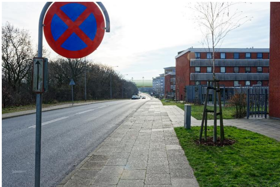
Figur 15.12 (Punkt 13, Skolebakken, maksimalt oplag. Der henvises til bilag 6 for visualisering af efter situationen) Den grønne mærkning viser det maksimale omfang af højt oplag i form af opretstående mølletårne. Bygninger på Etape 5 vil i begrænset omfang kunne ses. Bemærk, at den viste visualisering alene er til illustration af vurderingen, idet visualiseringer skal ses i helsideformat i bilag 6 for at give et retvisende indtryk af havneudvidelsens synlighed.
