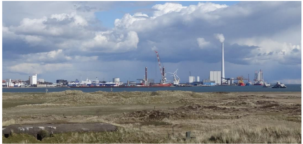
Figur 24.22. Udsigt på tværs af Vadehavet set fra klitlandskabet nord for Nordby mod sydøst. Herfra er afstanden til modstående kyst ca. 2 km. (Foto: NIRAS A/S)
