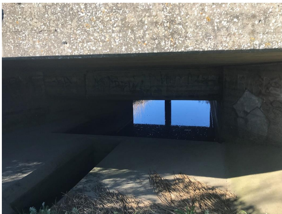
Bygværk på Præstegårdsbækken ved Mådevej.
