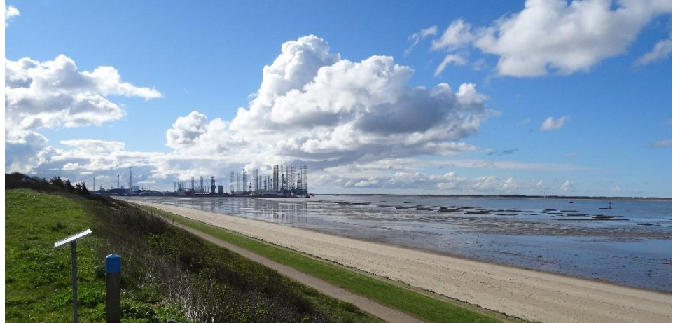
Figur 24.20 Udsigt på langs af kysten nord for Esbjerg Havn. Den eksisterende havn afskærmer projektområdet. (Foto: NIRAS A/S)
