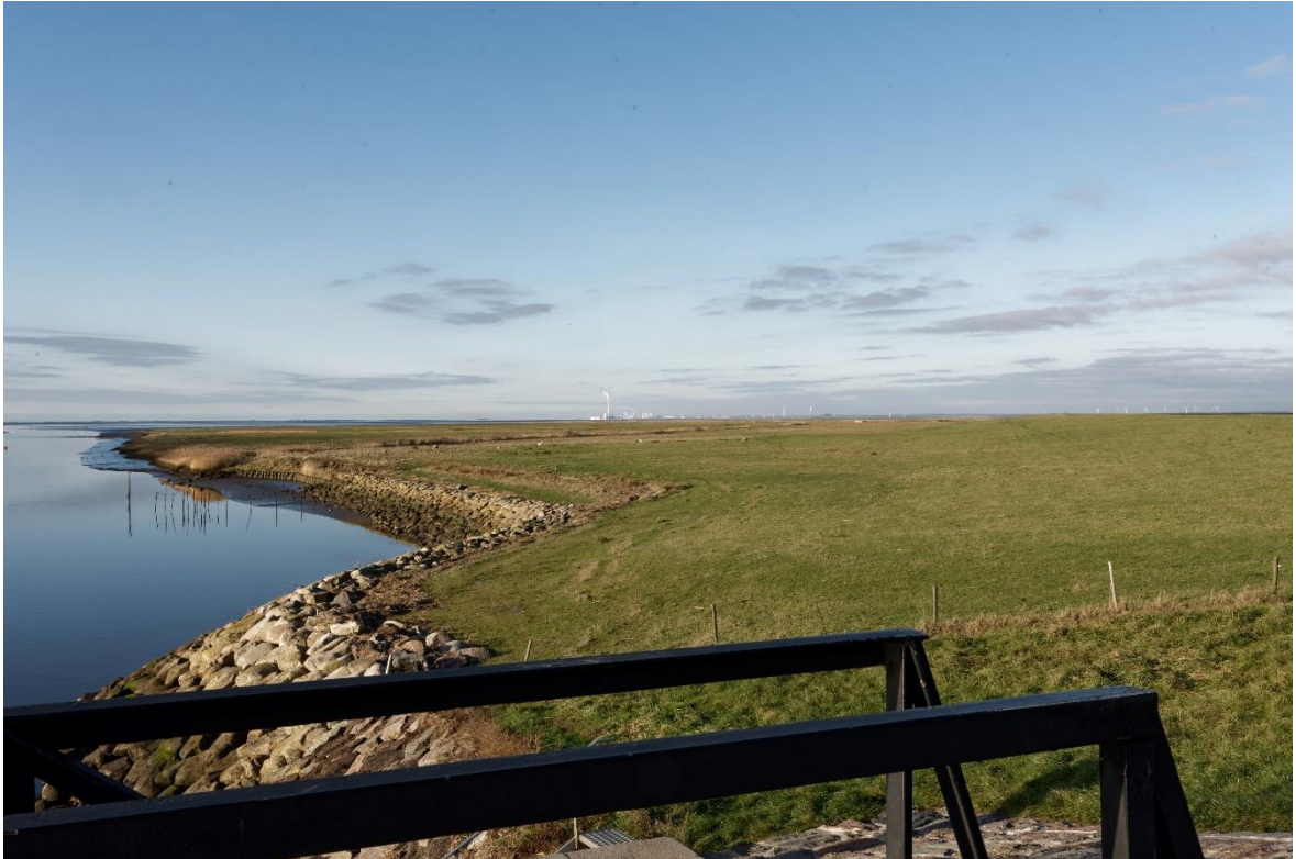
Figur 24.33 (Punkt 10, Kammerslusen, efter) Efter havneudvidelsen vil Esbjerg Havn ikke optræde betydeligt anderledes i landskabsbilledet. Bygningerne på Etape 5 vil stå neden for Esbjerg Bakkeø og ikke påvirke horisontlinjen.
