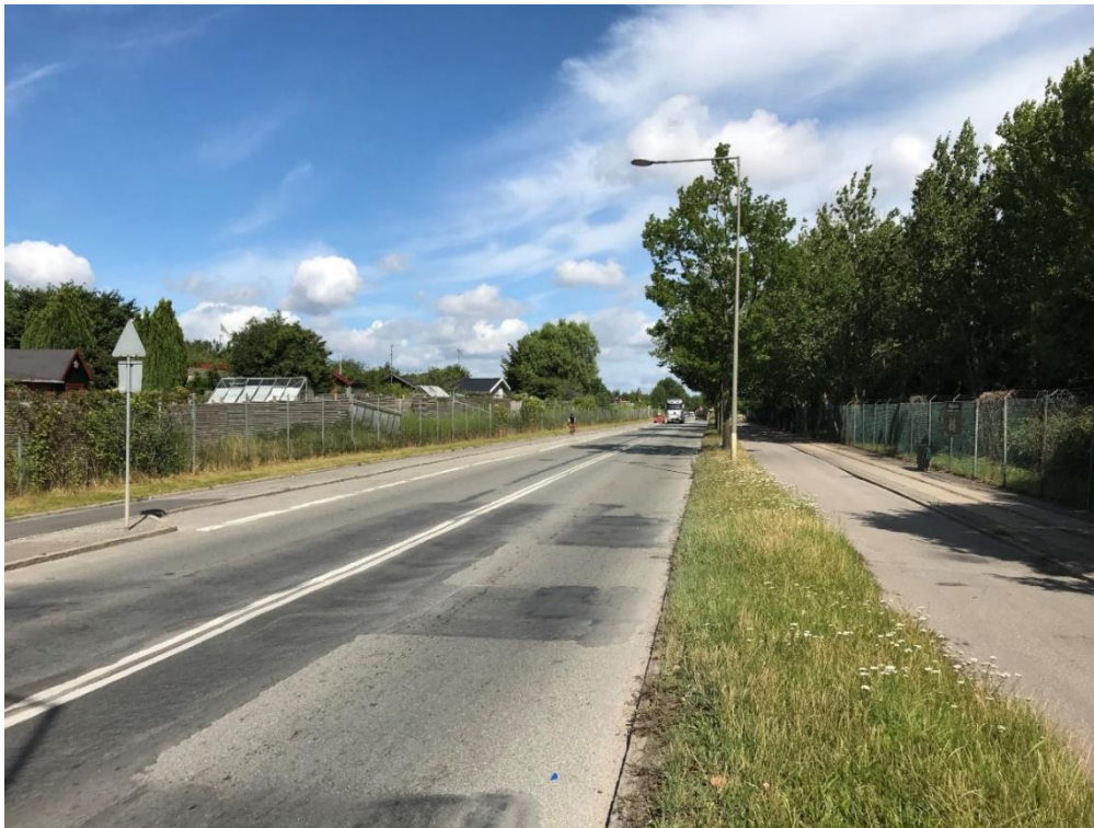
Figur 2-2 Eksisterende forhold på Forlandet syd for Kraftværksvej – set mod nord, 2020.
