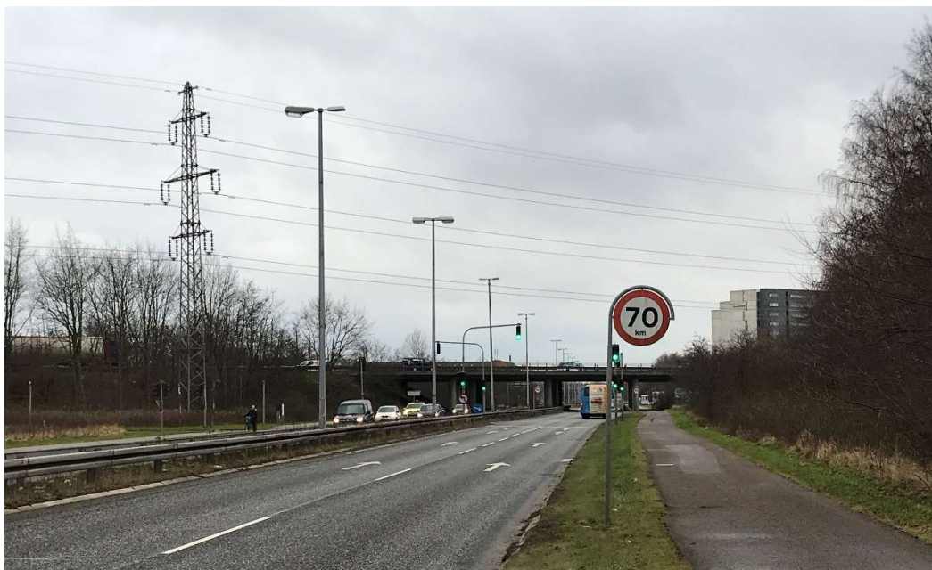
132 kV luftledning HL1277 mellem Ishøj og Brøndby. Mast 29 ved passage af Søndre Ringvej, Vallensbæk. Foto april 2018.
