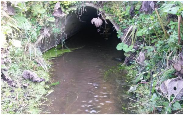
Figur 2 Eksisterende vandløbsunderføring for Valmosegrøften
