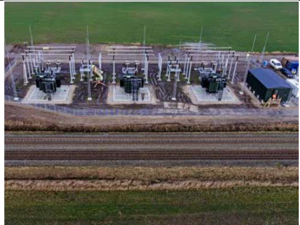
Figur 3: Eksempel på udformning af en TSS transformerstation
