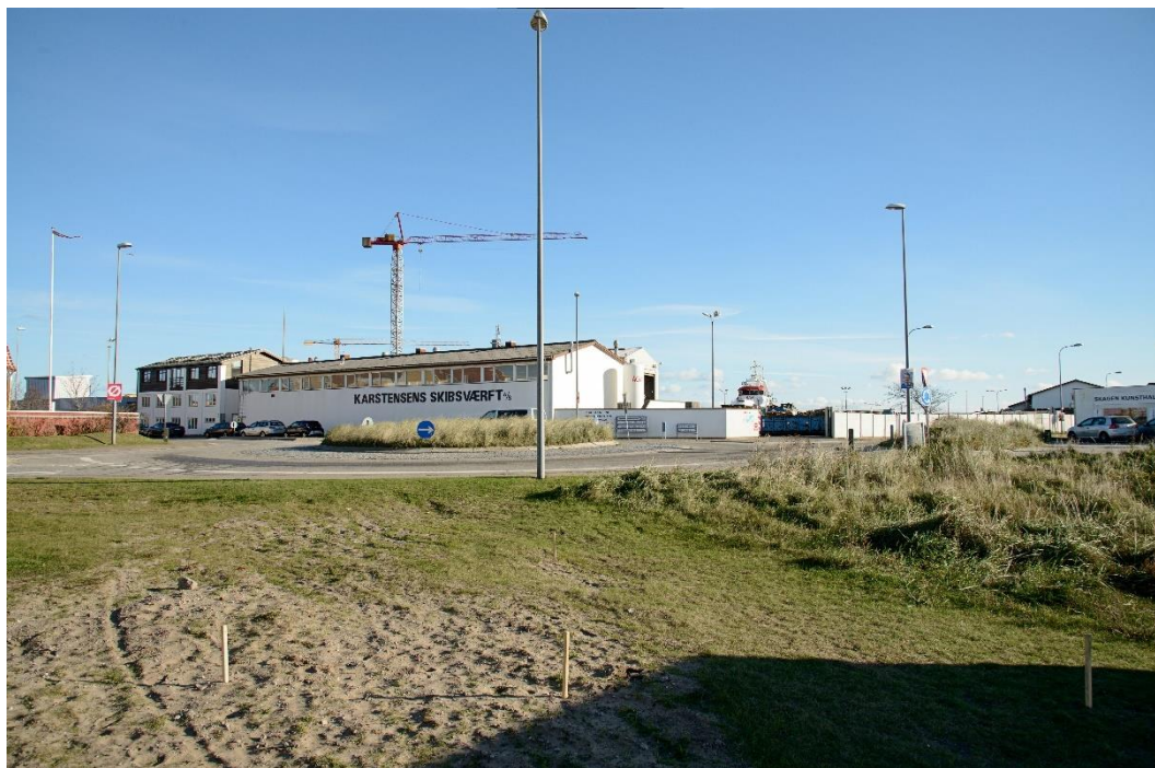
Figur 10-11. Eksisterende forhold fra rundkørslen Vestre Strandvej/Værftsvej. Fotostandpunkt 01. Oftere ligger der et skib på bedding 1, der vil tårne sig op over bygningerne og fremgå under kranen.
