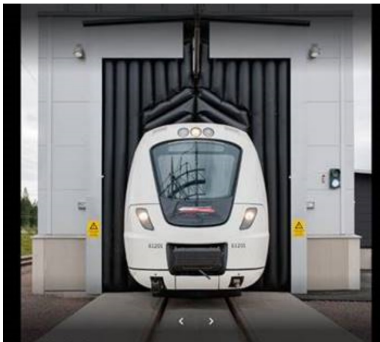
Figur 5-1 Modelfoto af oppustelig portvulst.
