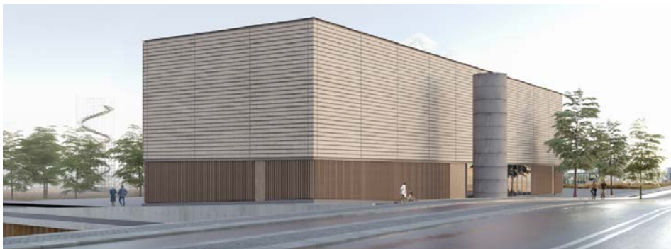
Figur 3: Illustration af energicentralen. Varmepumperne er placeret i bygningens grundplan, mens HOFOR Fjernkøling etablerer maskinanlæg på 1. sal. Ved siden af bygningen står et udluftningstårn tilhørende et spildevandsprojekt (U4).
